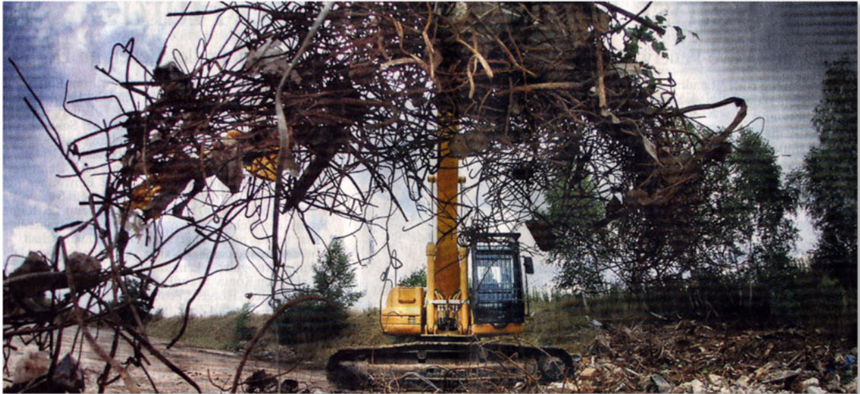
ANGEPACKT: Dem einstigen Gelände des Kreisbaubetriebes zwischen Oldisleben und Esperstedt rücken die Bagger zu Leibe. Die Natur kehrt zurück.
