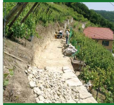
Sanierung des historischen Terrassenweinberges „Kaatschener Dachsberg“ (2003)
